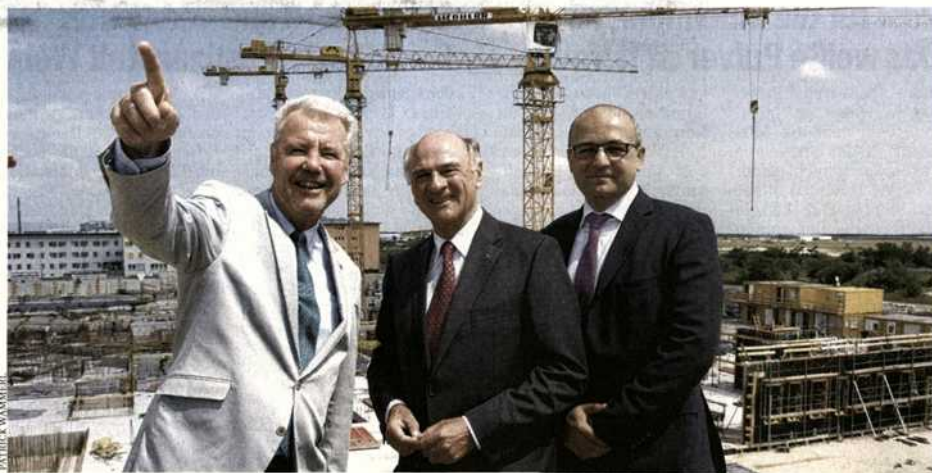
Kletterten am Mittwoch auf den 20 Meter hohen Schotterberg: Schneeberger, Pröll und Mößlacher inspizierten die MedAustron-Baustelle
