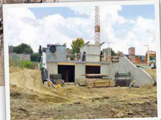
Als Fertigteil wurde die anthrazitfarbene Falltreppe in Sichtbeton bereits eingebaut.
